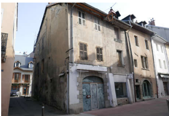
Le bâtiment et surface commerciale avant travaux
